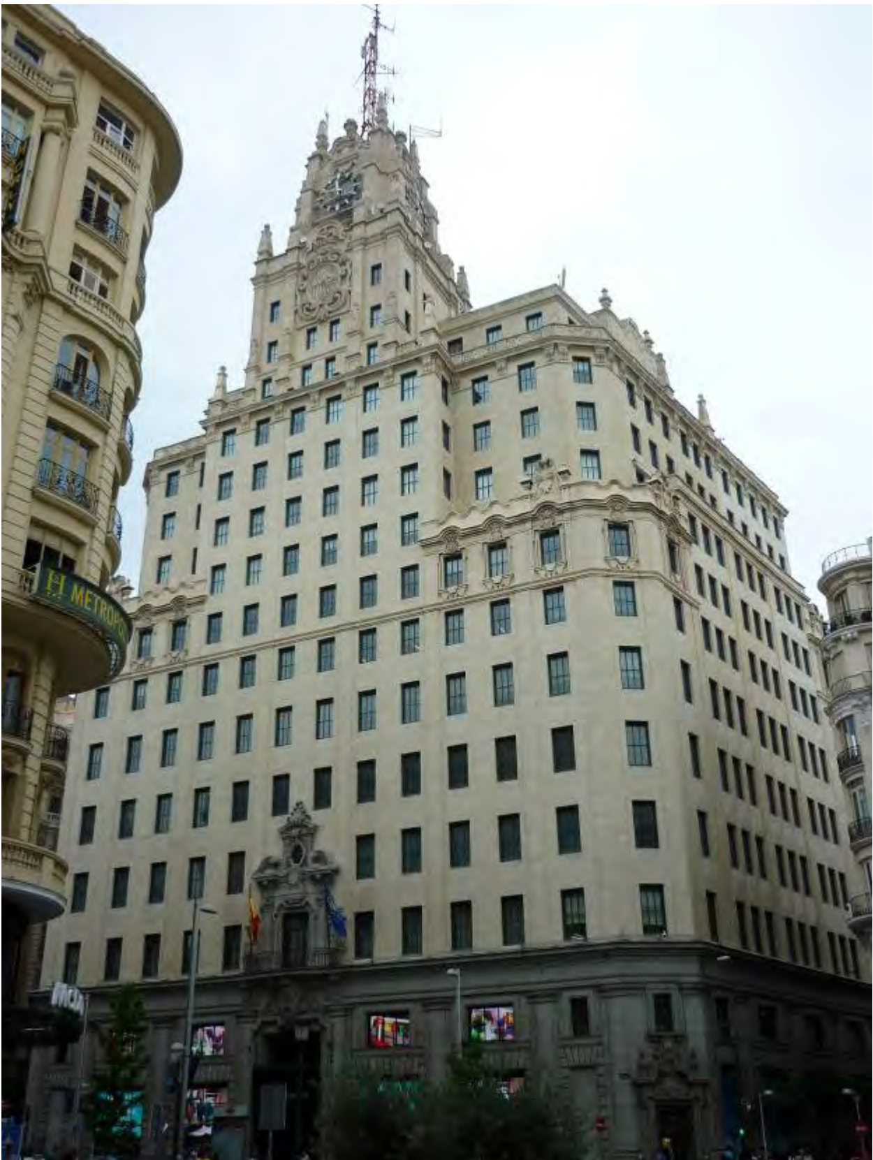
Telefonica : 1 er gratte-ciel de Madrid construit en 1929, haut de 81 mètres
